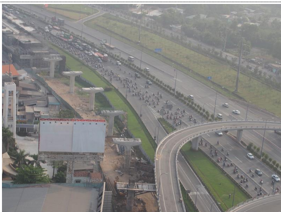
建設中の地下鉄と、横を走る大量のバイク
