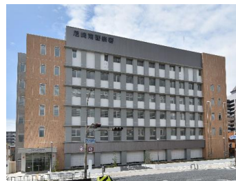
尼崎南警察署庁舎棟 ・電気設備工事 ・兵庫県尼崎市/2023年9月
