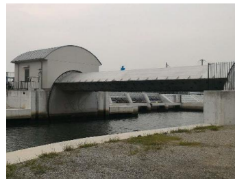
八家川第五ポンプ場 ・主原動機 ・兵庫県姫路市/2024年3月
